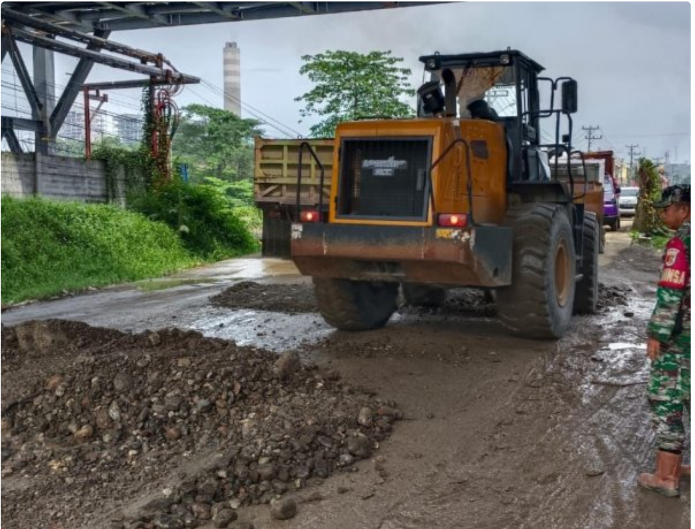
Penimbunan Jalan Rusak di Desa Labota
